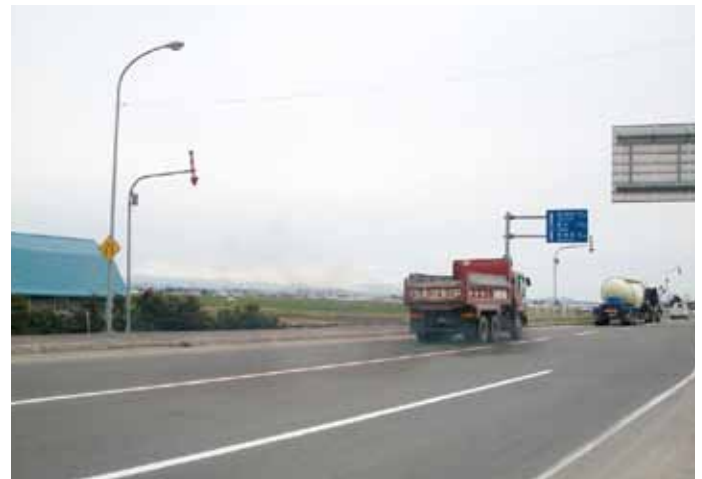
旭川東神楽道路として整備される道道
